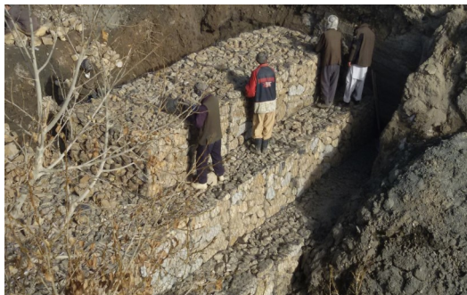
Construction d'un mur en gabions (Behsud I)
