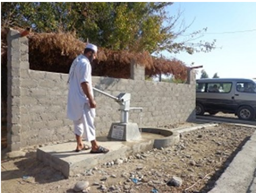
Construction d'un puit (province de Laghman)
