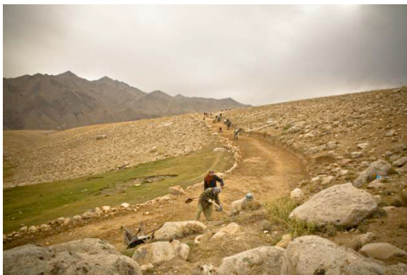
Réhabilitation de la route entre Abdara et Parwandi (Behsud)
